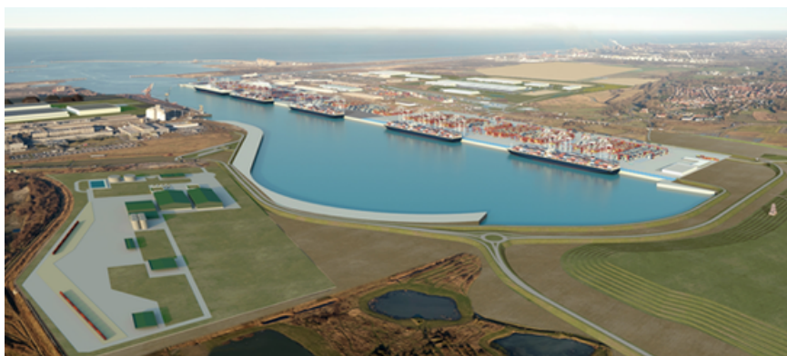
Projet de création d'un nouveau terminal portuaire (travaux en cours) [Source : Grand Port Maritime de Dunkerque]
